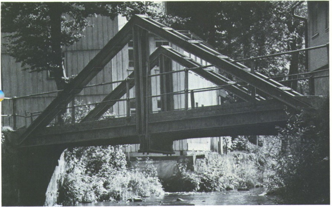
Abb. 14 Hängewerkbrücke bei Freudenstadt. Die Fahrbahn „hängt“ an der Dreieckskonstruktion. Die lotrechten „Hängesäulen“ in der Fahrbahnmitte, die die Längsträger der Fahrbahn durch
